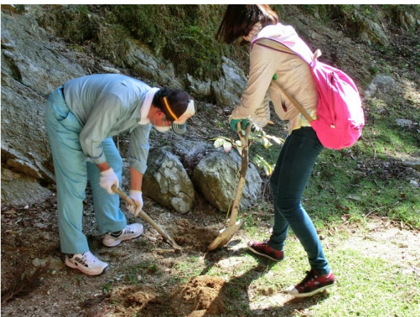
道路の補修作業。結構力がある作業です。
