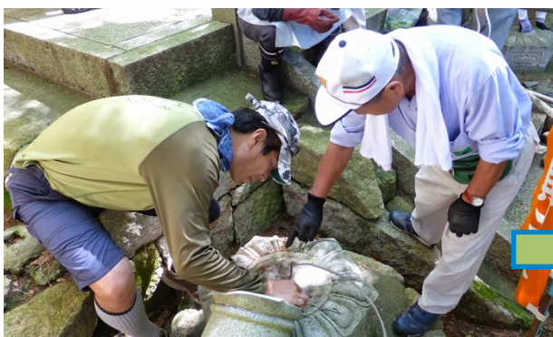
灯籠の復旧作業。高度な技術がいる作業でしたが、皆さん、アイデアを出し合い協力していました。
