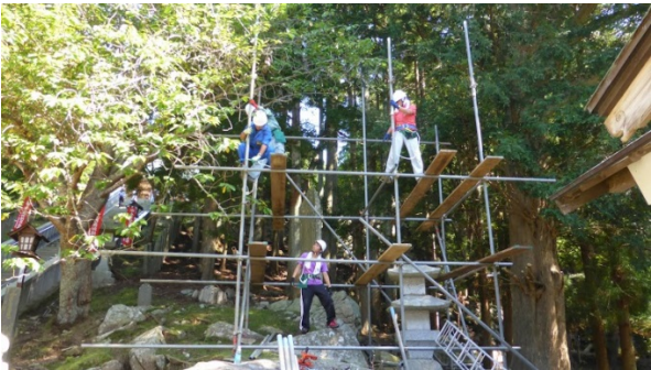
本格的な足場を使った灯籠の修復作業。 男性陣の腕の見せどころ
