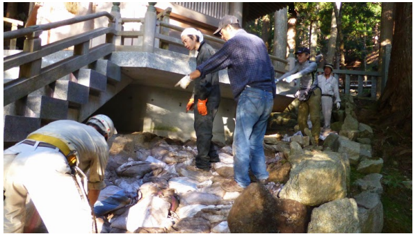
崩れた石垣の復旧作業。土嚢の積み上げや、石の配置など、地味に重労働の作業です。
