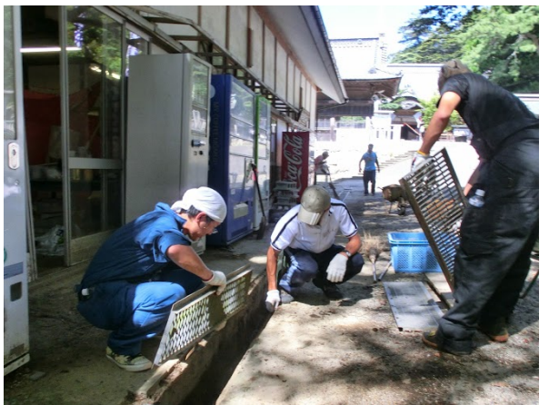
側溝の清掃作業。綺麗になると気持ち良いです。
